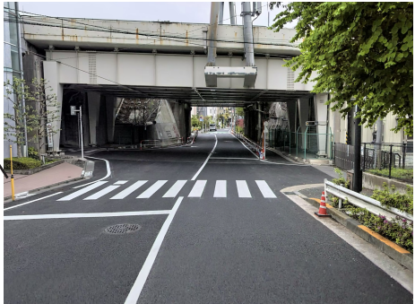
高架下 高さ 4.6M
